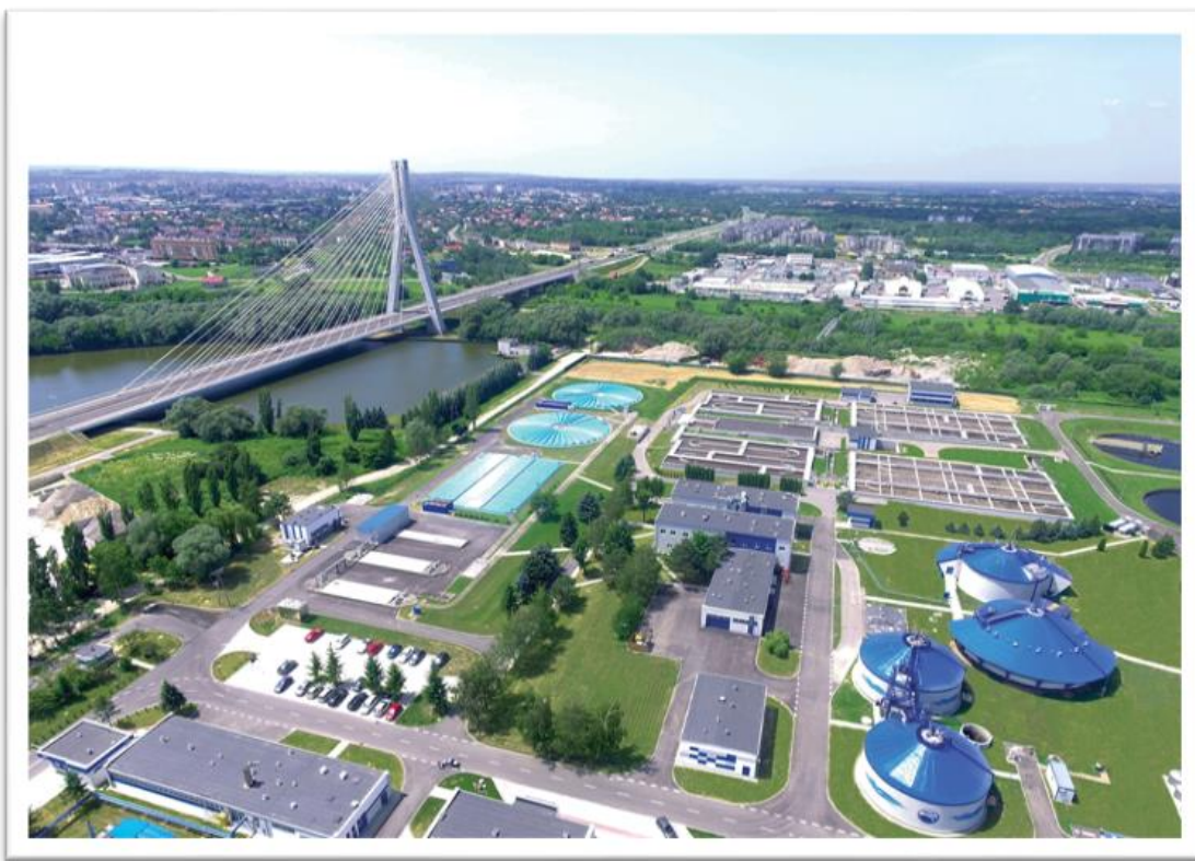
Oczyszczalnia Ścieków w Rzeszowie
